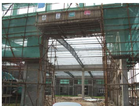
▲/图 二期生产附房建设现场
